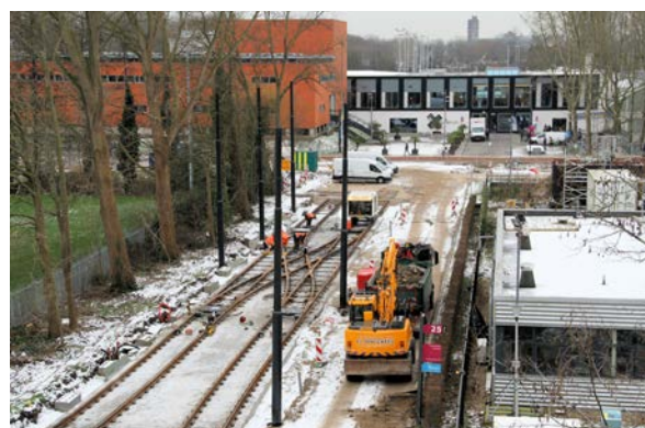
Werkzaamheden aan het wisselcomplex op de Broekweg tegenover gebouw X.
